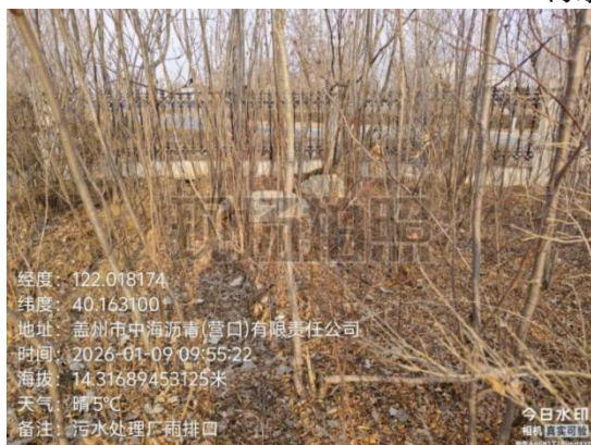
污水处理厂雨水排口
