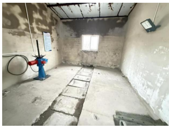
入海雨水排放口
