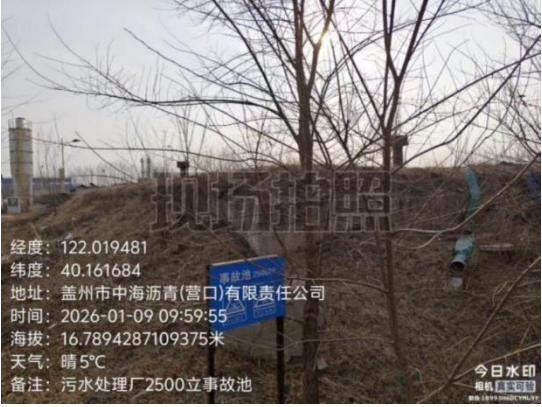
污水处理厂应急事故池 (2500m 3 )
