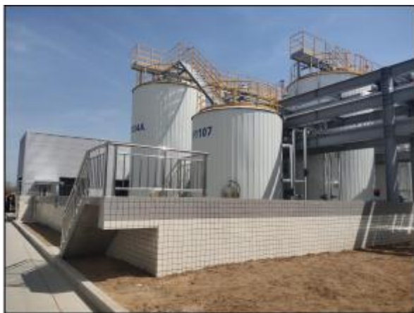
罐区围堰及导流装置
